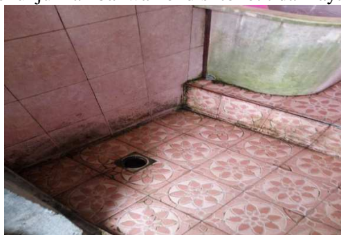
Foto 03. Kondisi dinding Toilet
