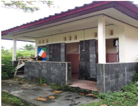
Foto 04. Foto kondisi sanitasi toilet
